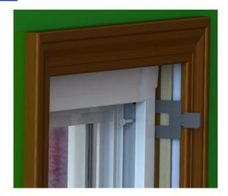
Ubica una cuña en cada uno de los agujeros pilotos, e inserta un tornillo en la esquina superior para sostener la ventana en su lugar. Remueve el tope del panel de la cabecera de la ventana y remplázalo cuando los tornillos se encuentren ajustados. Nota: Durante la instalación de todos los tornillos, asegúrate de ajustarlos para que la cabeza entre completamente o ligeramente texturizada para que el tornillo no interfiera con el equilibrio
